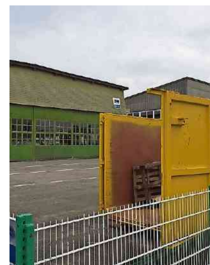
Die Umbauarbeiten haben begonnen.
